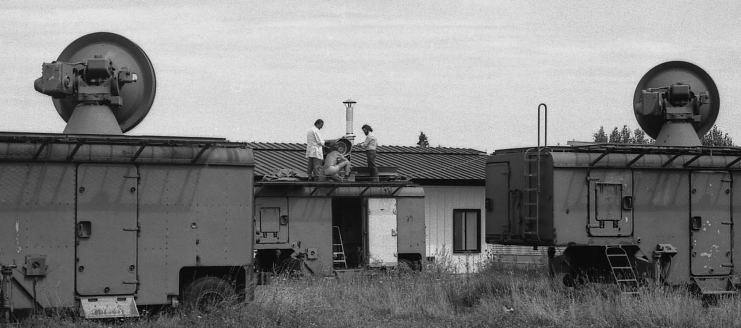
Les radars COTAL à Magny les Hameaux vers 1972, utilisés pour le radiosondage aux îles Kerguelen (Photo C.Niclot)
