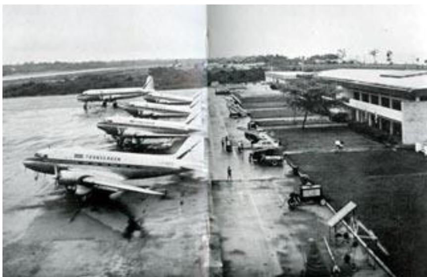
DC3 et DC4 vus de la tour
